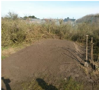
Abschlag 1 im "Rohbau"
